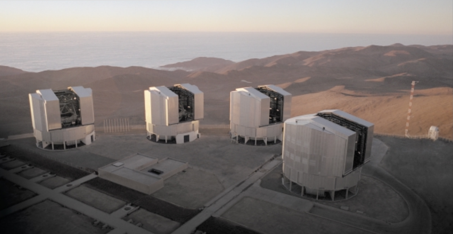
Bild 5: Ein Interferometer auf Cerro Paranal wird das Licht von zwei oder mehreren Teleskopen der ESO in einem unterirdischen Tunnel zusammenführen und wesentlich höher aufgelöste Bilder ermöglichen. Das VLT kann dann ein Teleskop mit 200 m Spiegeldurchmesser simulieren und bis zu 100mal schärfer sehen als Hubble. Für das Interferometer fertigt Carl Zeiss Spiegeleinheiten. (Aufnahmen 4 und 5: ESO).
